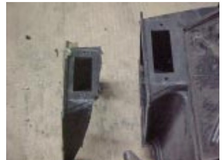
Cutting the fan box
